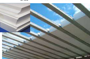
Concreto leve de EPS com 50 kg de cimento
